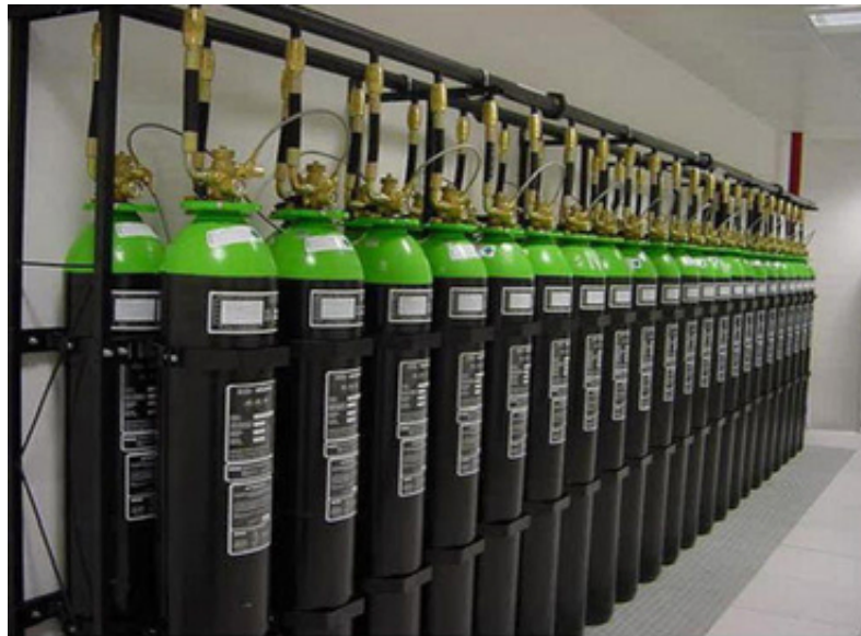
Systeme IG-01 Argon 200. Batterie consistant en 22 cylindres de 140 litres en deux rangs.
